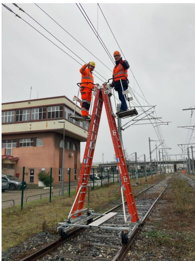
Essais terrain à Saint Priest avec 2 opérateurs
