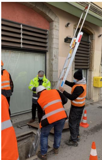
DACS - mise en place chambre
