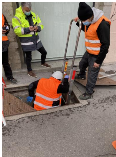
DACS - intervention en cours
