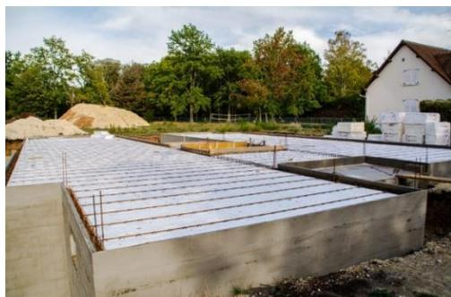
Pour cela, l'entreprise IDF Planchers a livré 750 mètres linéaires de poutrelles treillis, avec les entrevous en polystyrène expansé *Voutissimo® T 600* (coefficient de transmission surfacique de 0,23 W/m<sup>2</sup>.K) et les rehausses associées, Rehausse *Voutissimo® T*, proposées par Hirsch Isolation.
