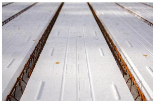
La pose soignée des entrevous et l'étaillage minutieux, réalisés par l'entreprise de maçonnerie Freitas, ont permis de limiter les chutes sur chantier, d'optimiser la découpe des hourdis et ainsi d'obtenir une finition exemplaire en sous-face (à joints décalés).
