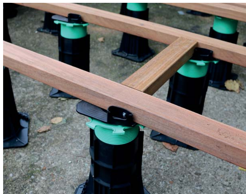
Maintien en position d'un étréssillon avant fixation.
