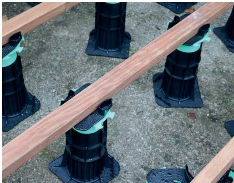
Pose et centrage des lambourdes (largeurs comprises entre 40 et 80 mm).
