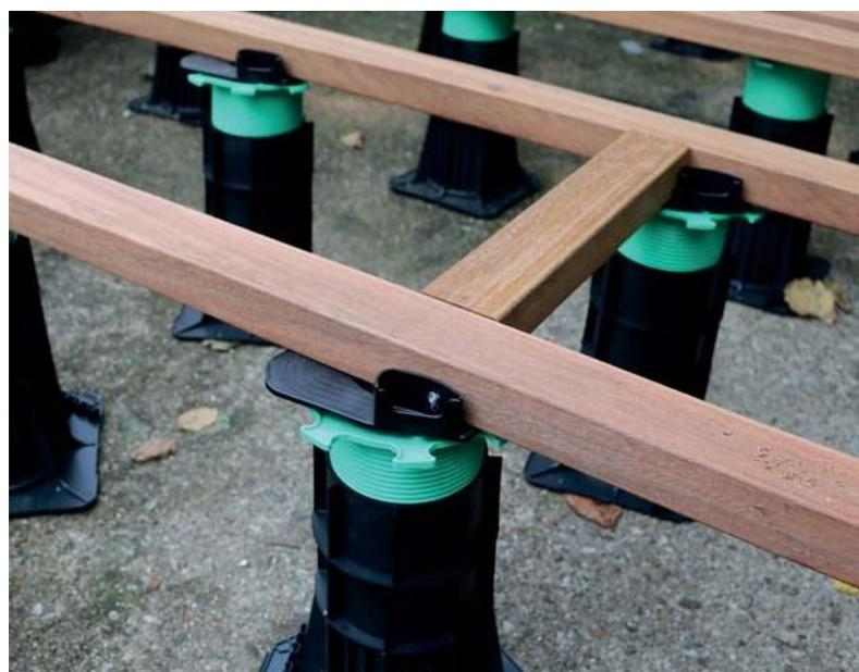
Maintien en position d'un étréssillon avant fixation.
