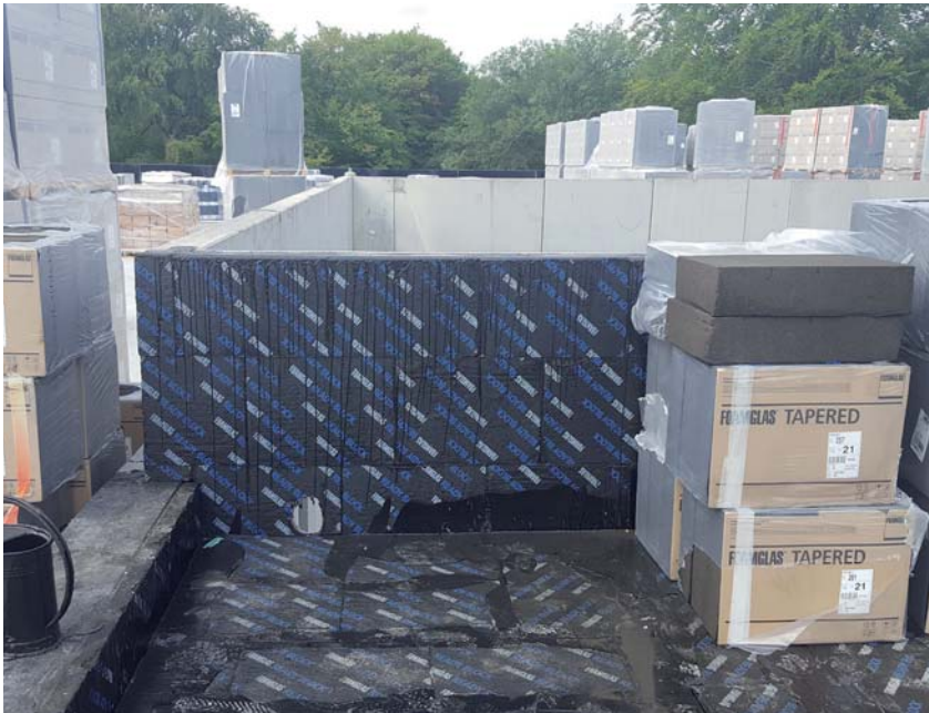
Roof Top de la résidence de CDC Habitat - rue de Belleville Paris 19 e @Groupe Arcane Architectes - @Bouygues - @FGE FOAMGLAS® TAPERED sur élément porteur en OSB : isolation en verre cellulaire de la toiture, avant étanchéité et aménagement
