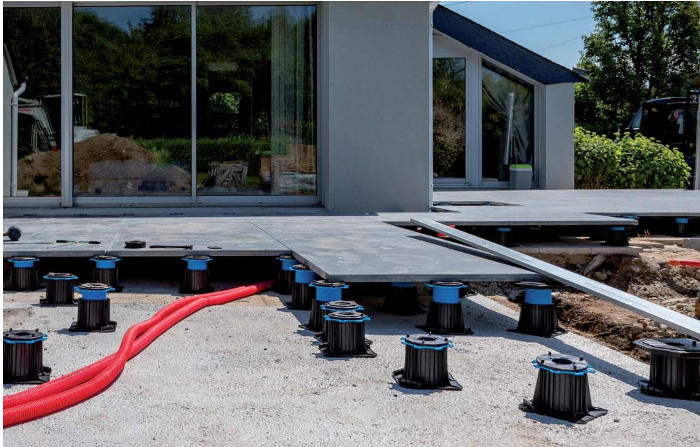
La gamme brevetée CLEMAN® JOUPLAST® est composée de plots standards (de 28 à 470 mm de haut) et de plots autonivelants (de 40 à 470 mm), avec utilisation de rehausse pour des hauteurs supérieures à 230 mm. Pour une pose optimale, ils offrent 3 niveaux d'utilisation : préréglage des plots avec l'embout de vissage au début du chantier, réglage manuel de la hauteur avec l'écrou pendant le chantier, et ajustement de la hauteur avec la clé CLEMAN® (sans retirer le dallage) à la fin du chantier.
