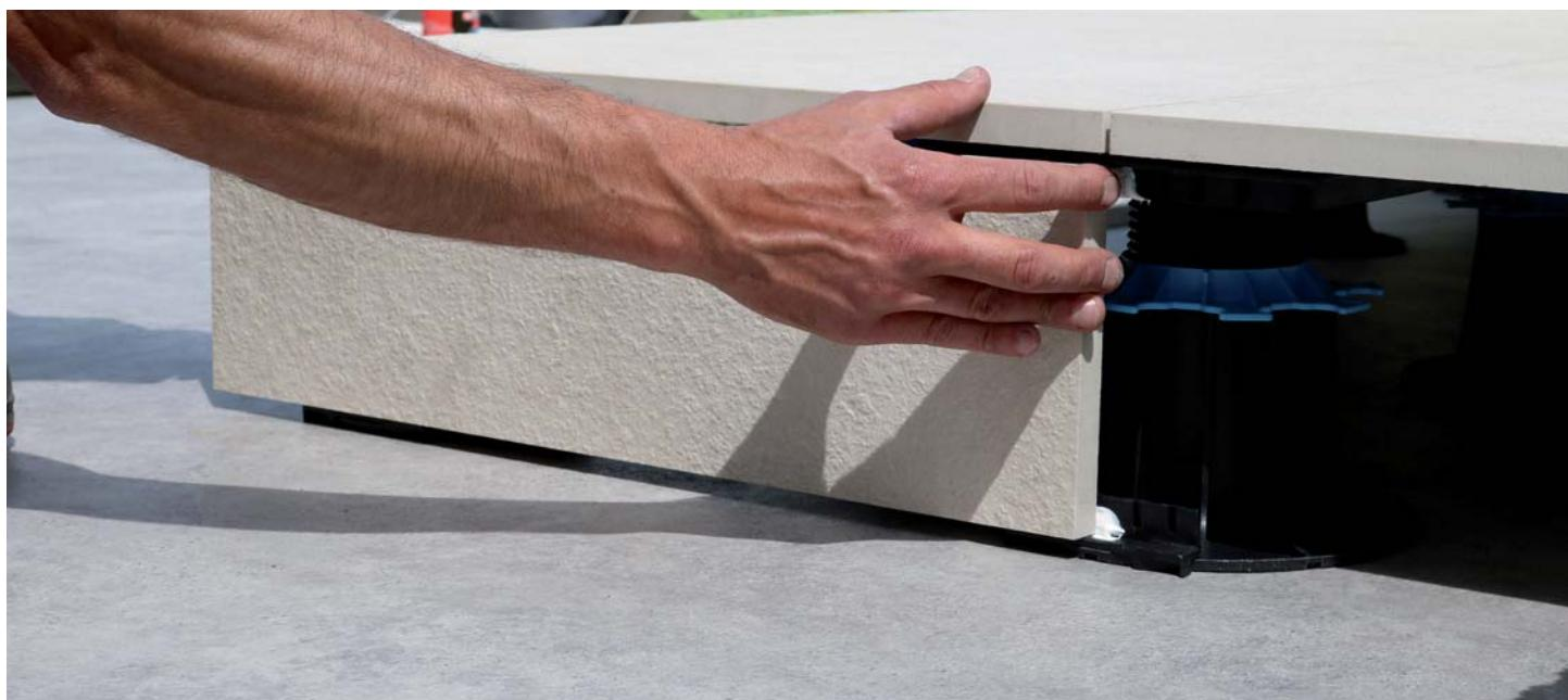
Les plaques à dalles JOUPLAST® se positionnent sur la tête des plots ESSENTIEL et CLEMAN® en périphérie de terrasse. Que ce soit pour une finition latérale avec découpe de carreaux ou avec un profilé clipsable, les plaques à dalles JOUPLAST® permettent de réaliser des fixations invisibles et ergonomiques.
