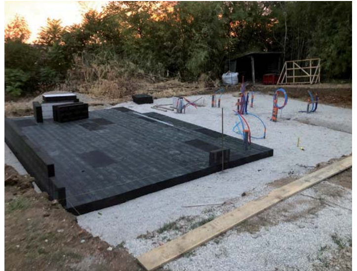
Maison isolée en sol et murs enterrés en verre cellulaire
