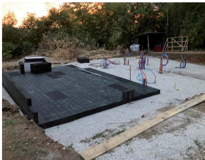
Maison isolée en sol et murs enterrés en verre cellulaire
