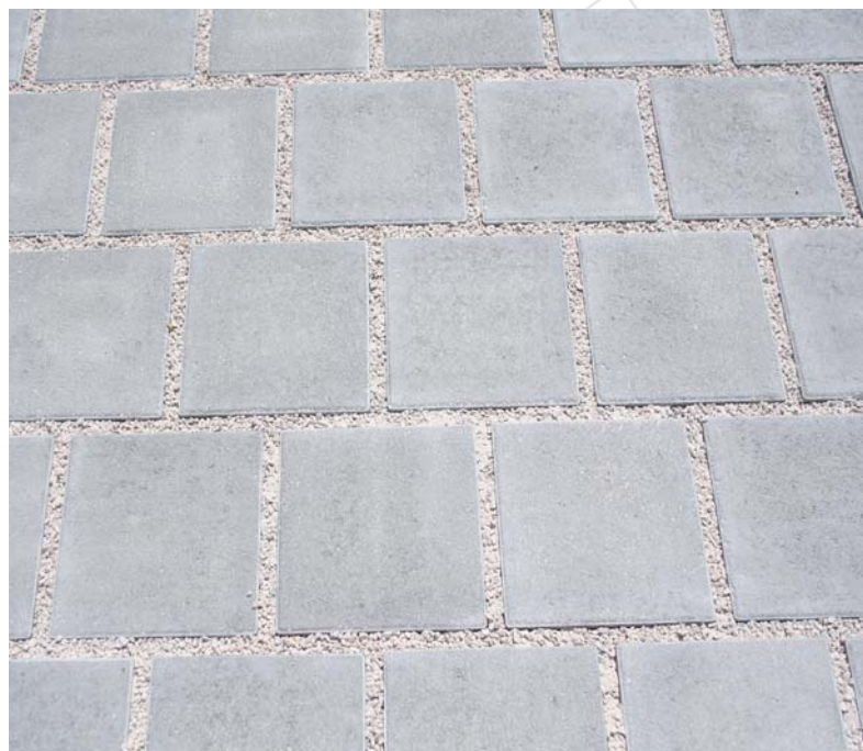
Pavés drainants Carus - pose à joints croisés
