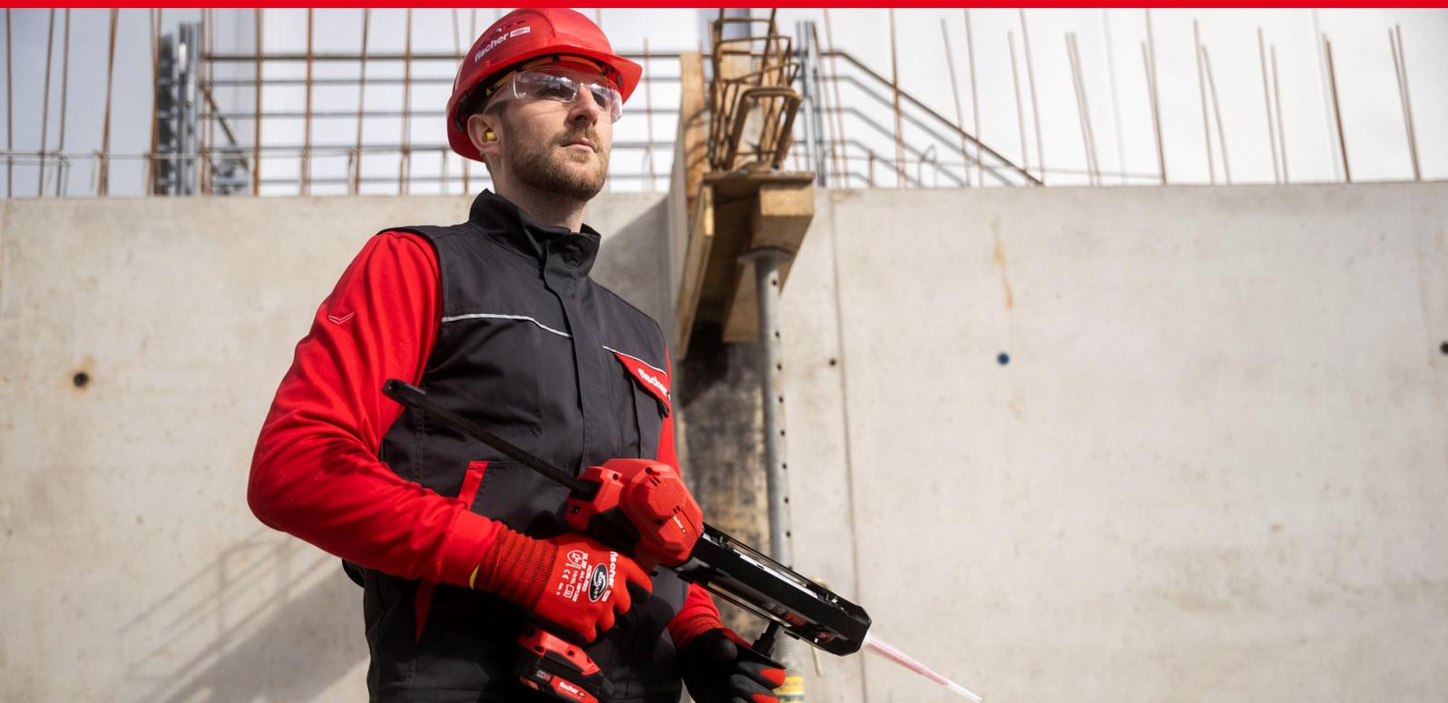
La cartouche contient les 2 composants (résine et durcisseur stockés séparément) qui se mélangent et s'activent dans le bec mélangeur. La résine est ensuite injectée dans le trou de perçage nettoyé. Une fois le fer à béton inséré, la FIS RC II va se fixer sur toute la surface du fer à béton et sur la paroi du forage pour sceller solidement l'ensemble.
