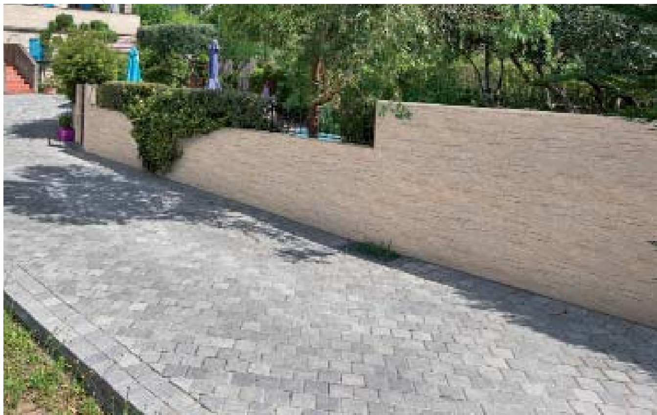
Parement de mur THOLET
