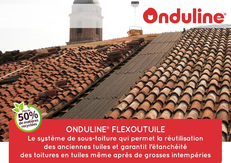
En France, la plupart des toitures sont recouvertes de tuiles différentes en fonction des régions (tuiles canal, tuiles plates ou mécaniques). Ce mode de couverture est apprécié pour sa fiabilité. Mais pour garantir une étanchéité pendant 30 ans, il doit être associé à un système de sous-toiture adapté.
