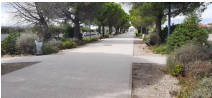
Appliqué sur une grave non traitée (gravier compacté permettant aux eaux pluviales de s'écouler), Résineo® répond à de multiples critères environnementaux dans le cadre de la rénovation des espaces piétonniers sur le parc des expositions de Montpellier : « Composé à plus de 95% de granulats minéraux et perméable, le revêtement Résineo® favorise une meilleure gestion des eaux pluviales et limite également les îlots de chaleur. Ce sont précisément ces arguments qui nous ont amené à proposer
