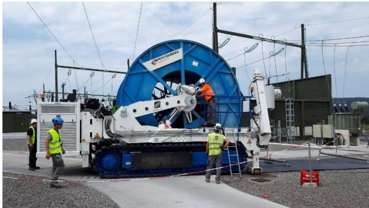
**Innovation :** la Dérouleuse à chenilles porte tourets de grandes dimensions répond à l'équation complexe des chantiers de déploiement de réseaux électrique sur des terrains de nature très variable et prenant en charge les nouveaux de tourets de déversement, dont les dimensions
