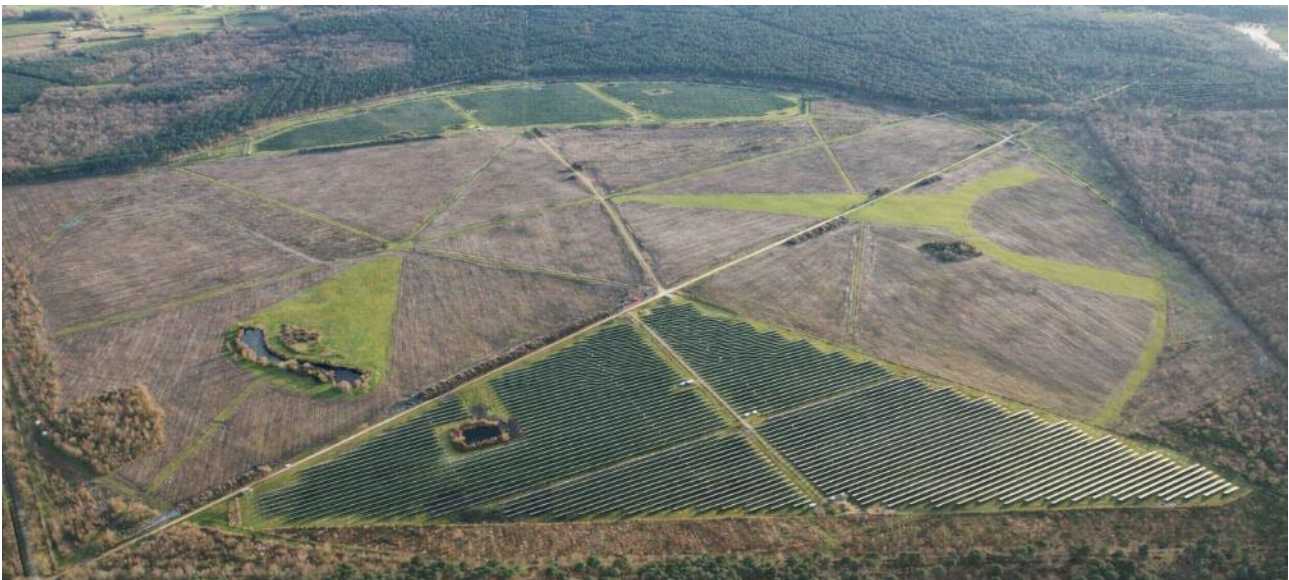
Vue aérienne de l'emprise des Champs Solaires de Touraine – Crédit photo Quercus Energies
