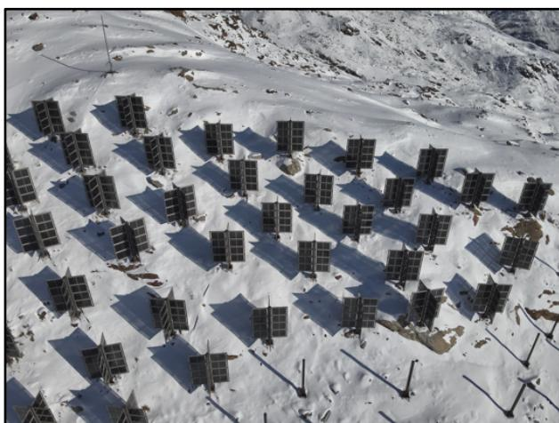
**Légende :** Une nouvelle centrale solaire à grande échelle d'environ 6,3 MWc, comprenant quelque 800 structures HELIOPLANT® ainsi que des onduleurs et des optimiseurs de puissance SolarEdge, est actuellement en construction à Sölden, en Autriche, à une altitude comprise entre 2 850 et 3 000 mètres. (source de l'image : HELIOPLANT®)
