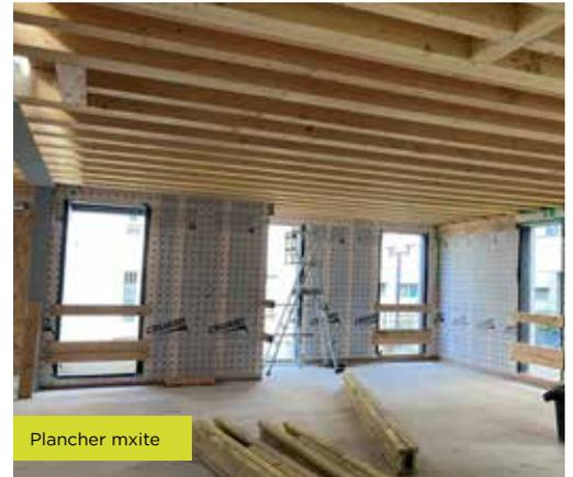
Les planchers du R+1 au R+5 sont réalisés en plancher mixte bois béton avec des solives en lamellé collé connectées à une dalle en béton armé de 8 cm d'épaisseur à l'aide connecteurs métalliques. Cette solution mixte est légère. Sa performance technique est supérieure aux planchers béton armé classiques.
