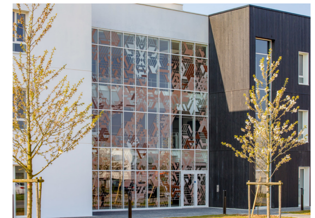
Lek, Sans Titre, 2019, Isneauville. Maître d'ouvrage : Pierre de Seine, programme « Hémisphère », architectes : Cabinet Artefacte - Philippe Plouchard © Julien Tragin
